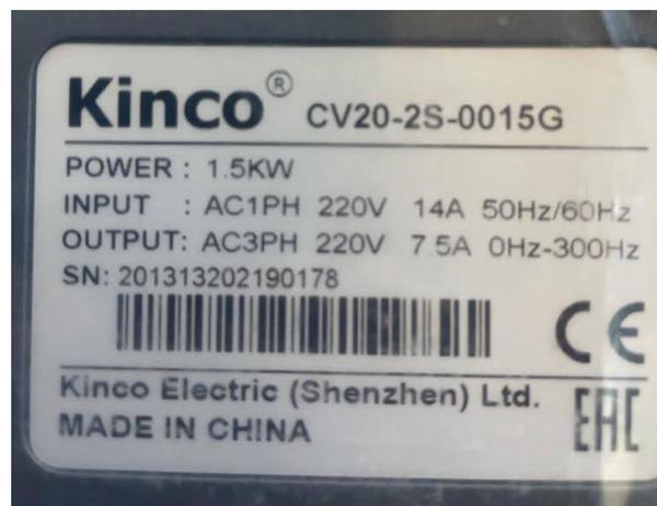
*Nota.* El variador de frecuencia de la marca Kinco, modelo CV20-2S-0015G, es un modelo que permite el ingreso de dos fases de alimentación, y genera a su salida tres fases.
