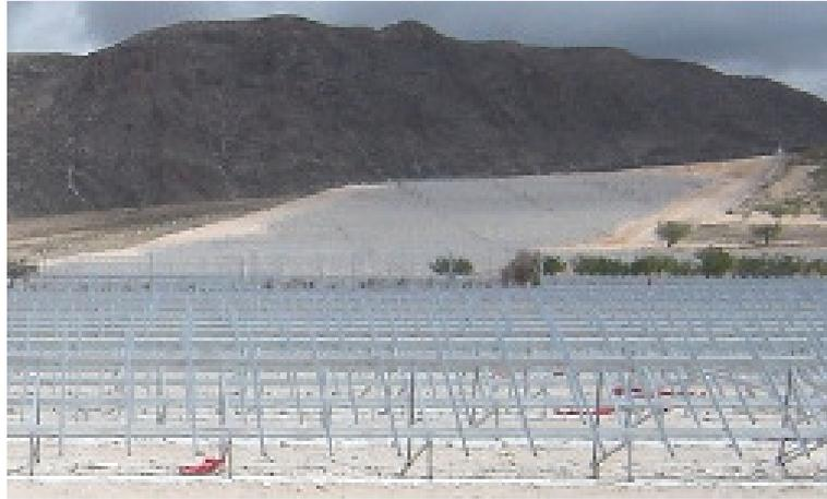
**Figura 2.16** Estructura metálica fija para paneles fotovoltaicos.<sup>46</sup>
