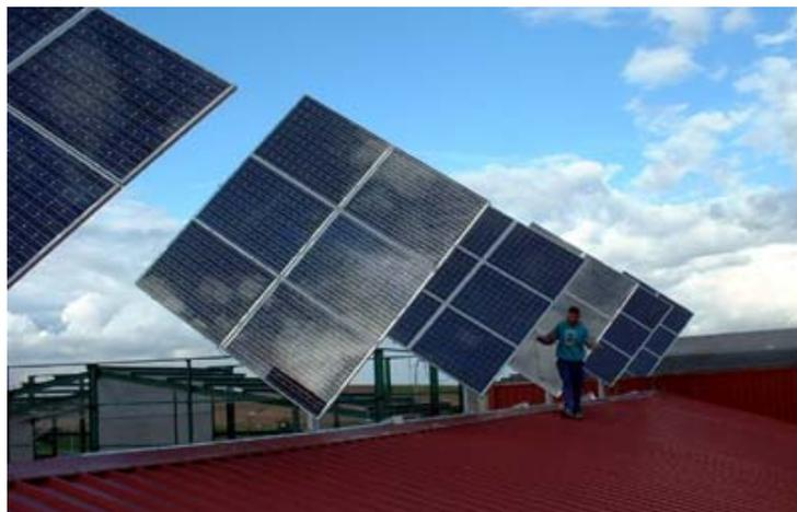
**Figura 3.9** Sistema de accionamiento manual
