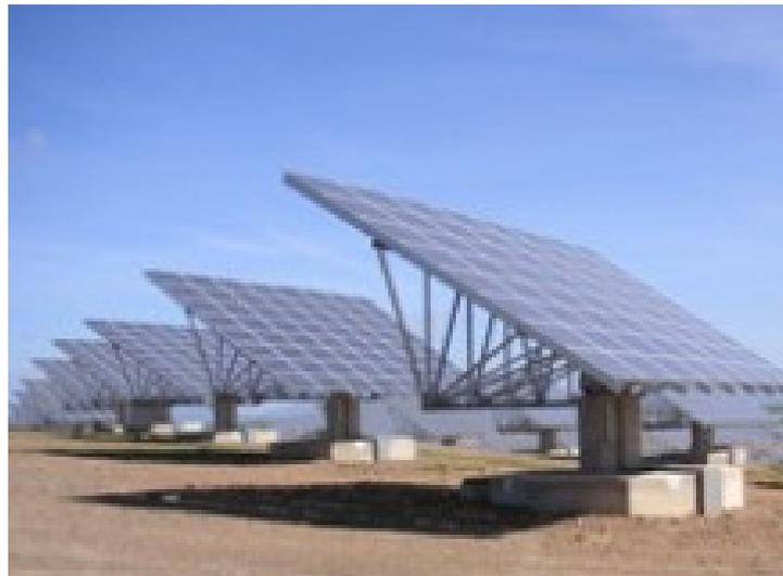
**Figura 2.17** Estructura metálica móvil en 2 ejes para seguidor solar.<sup>48</sup>
