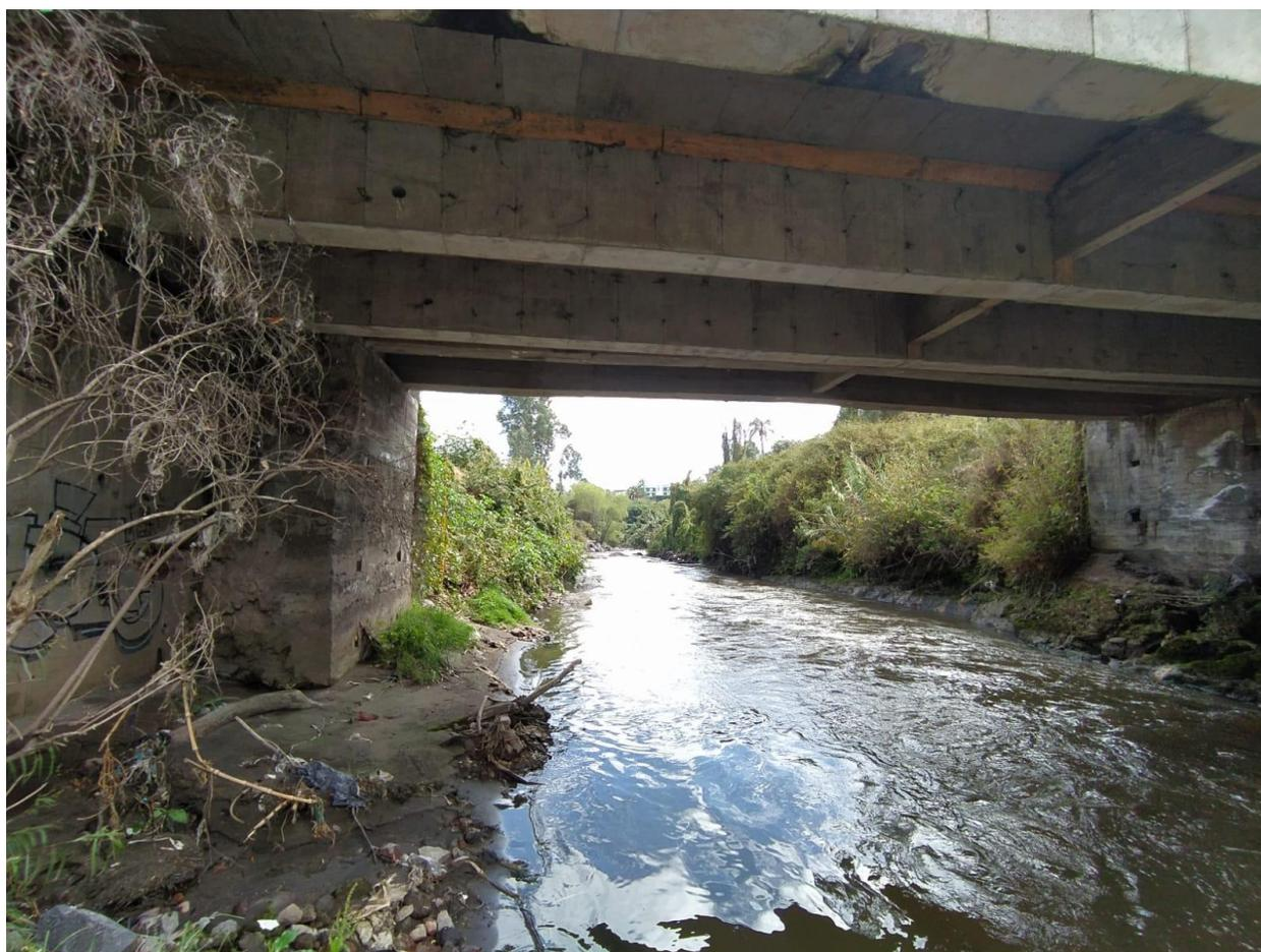
En la sección del puente, se puede observar 2 muros de hormigón que limitan la sección del río por lo tanto no existen taludes naturales en esta sección. Además la profundidad del agua es mayor, como consecuencia, la velocidad es mayor en esta punto. Una característica del puente analizado es que los taludes laterales cerca de los muros son muros de gaviones que en su base están sumergidos por el agua, lo que sería resultado de una socavación debido a la velocidad del río.
