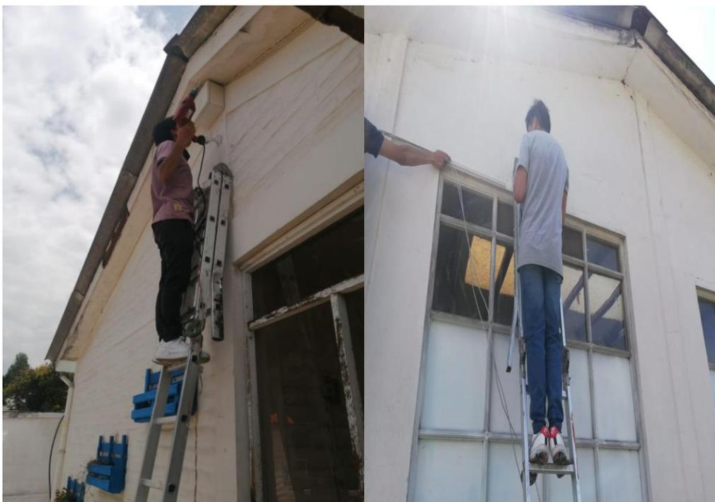
*Nota.* La figura representa como se realiza el cableado y colocación de cámaras IP.
