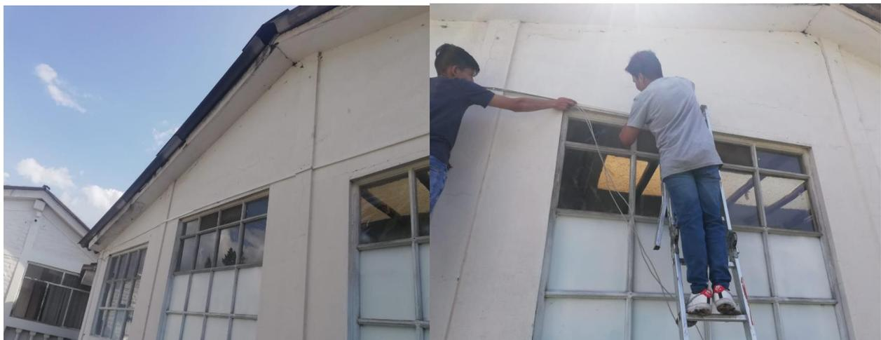
*Nota.* La figura representa la colocación de canaletas para guía del cable.
