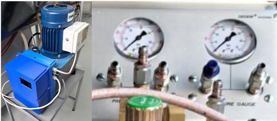
*Nota.* Se llevo a cabo acciones de limpieza en la bomba hidráulica, instalación de nuevos manómetros y el remplazo de la carcasa exterior.
