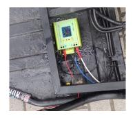
*Nota.* En la figura se observa ya conectados los bornes referentes a la carga tanto del controlador como baterías.
