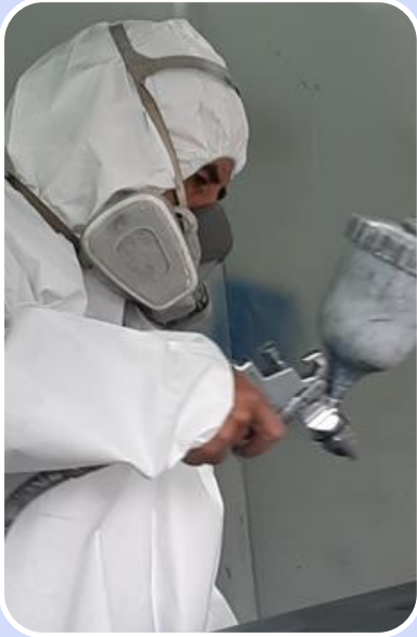
Aplicación de pintura
