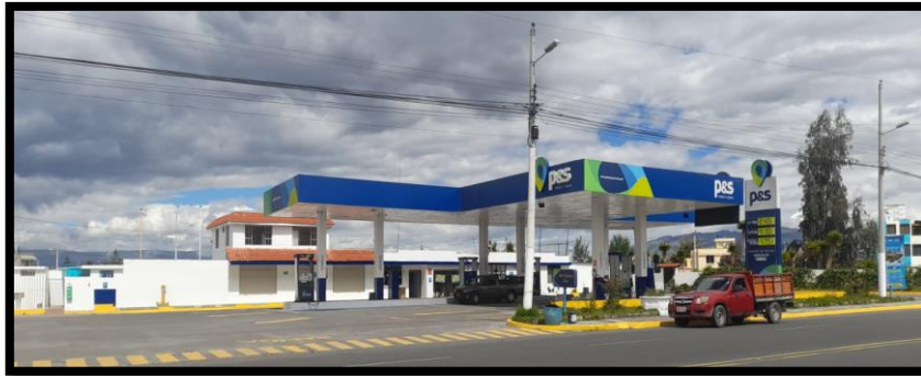
Gasolinera P&S Merizalde Cantón Pujilí
