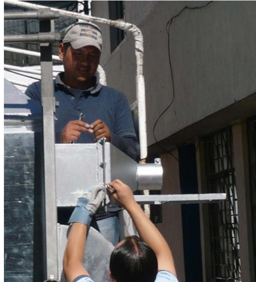
Figura 5.19 Ensamblaje del Recolector del aire de proceso
