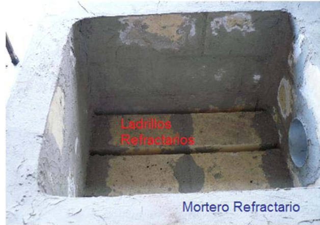
Figura 5.4 Recubrimiento refractario.
