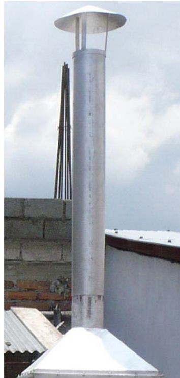
Figura 5.21 Ensamblaje del recolector de gases y tiro.
