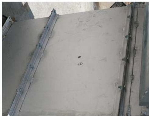
Figura 5.34 Construcción por módulos, facilita las tareas de mantenimiento.
