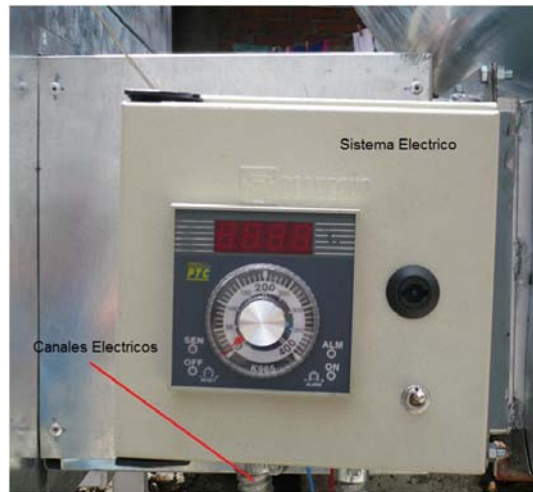
Figura 5.24 Ensamblaje sistema eléctrico
