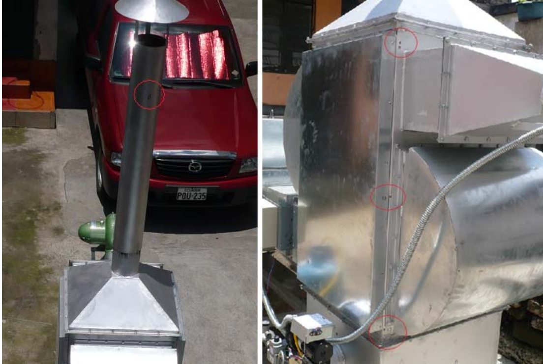
Figura 6.10 Marcación de puntos de medición – Intercambiador y Plenum.
