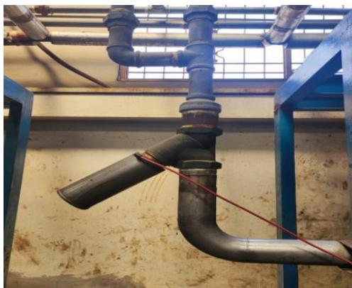
**Figura 30***Sistema de ingreso de Vapor*
