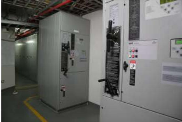
Cualquier mecanismo tiene el actuador, sistema de control que generará órdenes para ejecutar una acción determinada. El sistema de transferencia automático, contiene equipos de fuerza, control, supervisión, de medida, comandos y protección.
