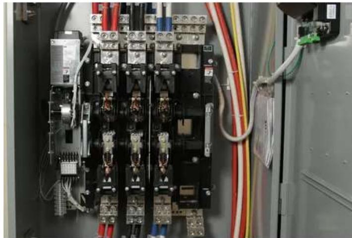
**Transferencia cerrada.** - Dispone de un sistema de conmutación de potencia capaz de realizar una sincronización momentánea de ambas fuentes durante 20ms tanto en retransferencia como en transferencia de carga programada, disponen de controladores adecuados para controlar las fuentes, activan su mecanismo de transición cuando existen recursos disponibles.
