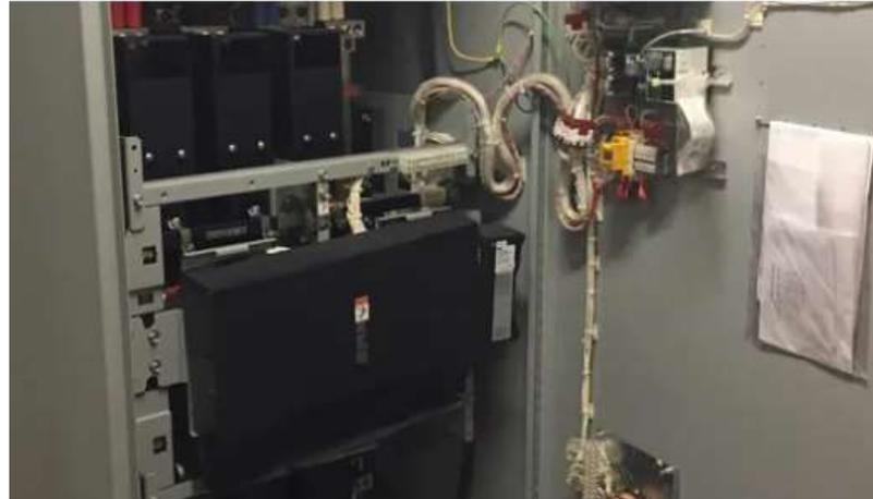
**Transferencia carga suave.** - el sistema se utiliza para cargas muy críticas, es capaz de controlar la fuente del grupo generador de forma que se desarrolle el flujo de energía. Con esta transición, se puede eliminar cualquier posibilidad de que las fluctuaciones de energía afecten a las cargas eléctricas. Entre las principales funciones están las instalaciones industriales, locaciones petroleras, equipamiento médico hospitalario, data center.
