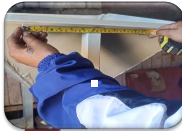
Colocación de tolva
