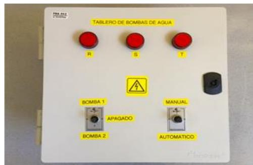
*Nota.* Ilustración de un tablero de control de un motor eléctrico (Hidalgo, 2013).
