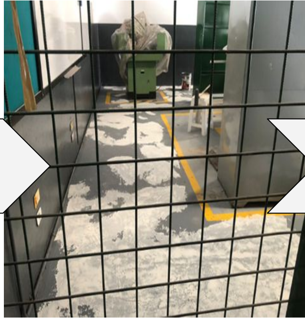
Aplicación de pintura de base y corrección de fallas
