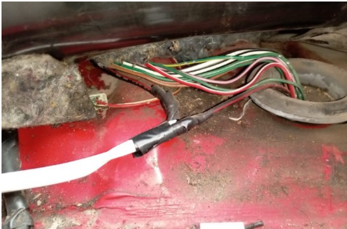
Corte para conexión del relé
