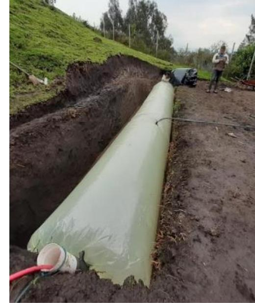
**Figura 10.** Llenado de agua para sello hidráulico
