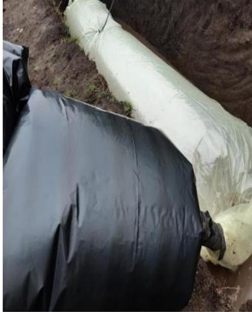
**Figura 9.** Biodigestor inflado colocado en la zanja
