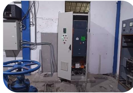
Instalación de variador de frecuencia y tableros.
