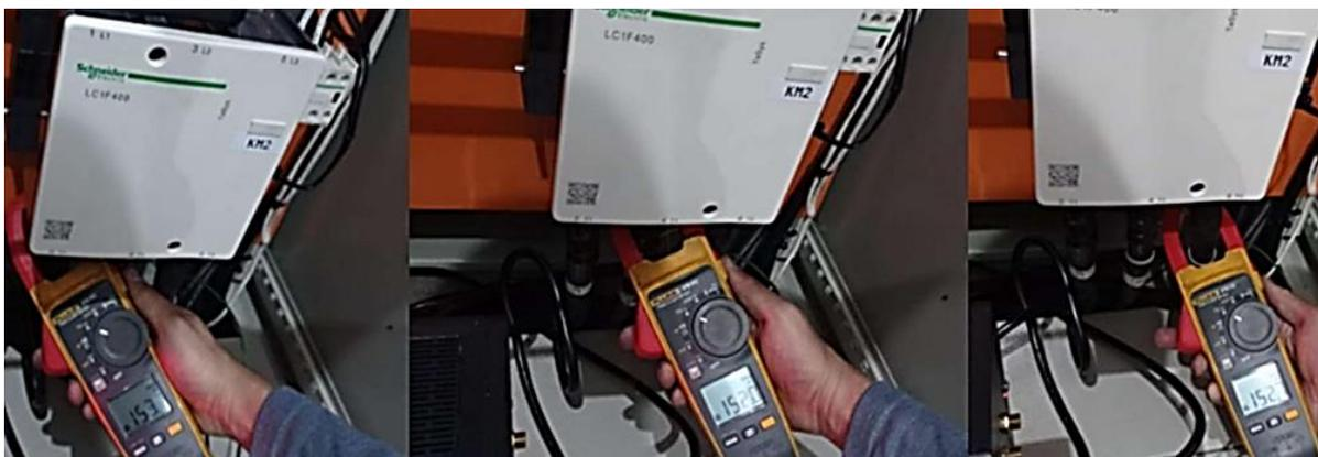
Esta prueba es realizada con el fin de garantizar un equilibrio entre el consumo eléctrico y permitir un funcionamiento eficiente de los equipos instalados.
