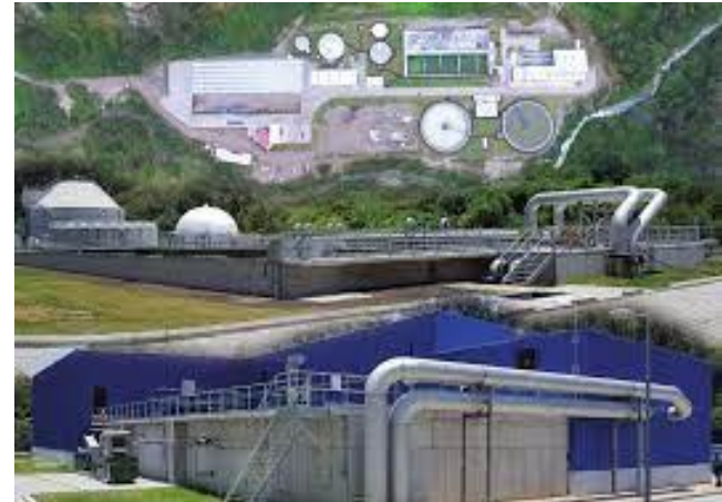
FIG. 3 Planta de tratamiento de agua residual
