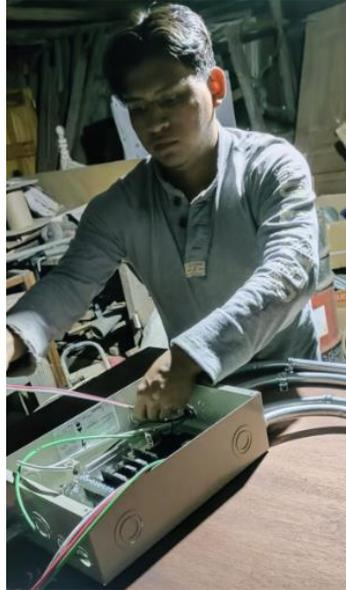
*Nota.* Utilización de cable THHN calibre #12 AWG
