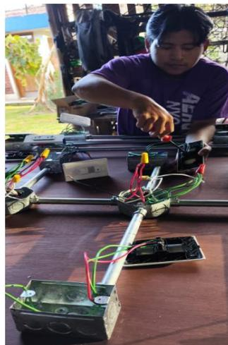
De acuerdo con la normativa NTE INEN 2345, se procedió a utilizar el cable THHN calibre #14 AWG para la conexión de un interruptor doble cumpliendo con la normativa IEC 60669-1. La línea de fase (Rojo) ingresa al interruptor doble, mientras que dos líneas de retorno (Negro) se derivan para conectarse a las respectivas boquillas de porcelana. Por otro lado, las dos líneas de neutro (Blanco) se conectan también a las boquillas de porcelana correspondiente, tal como se muestra en la figura 74.
