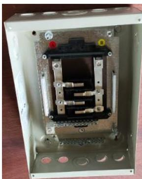
*Nota.* Se utilizó tornillos y rodajas con una llave 10 para sujetar el centro de carga en el tablón.
