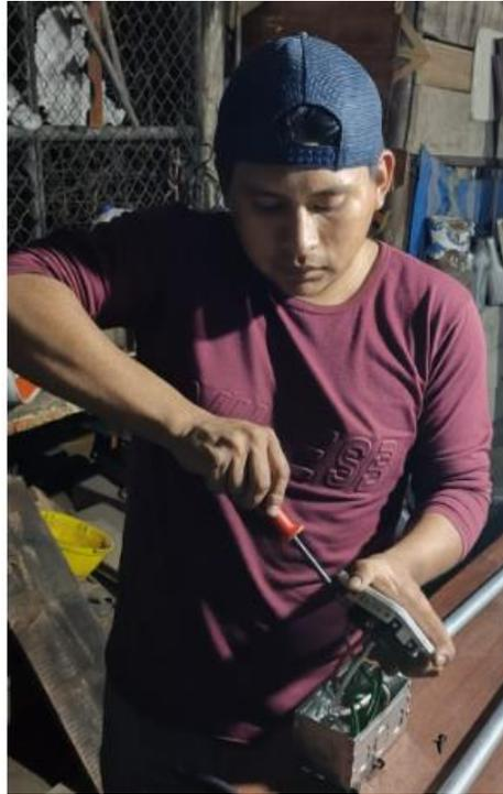
*Nota.* Conectado al interruptor termomagnético Square D de 1 polos de 32 A.
