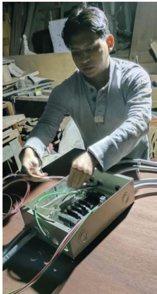
*Nota.* Utilización de cable THHN calibre #14 AWG,
