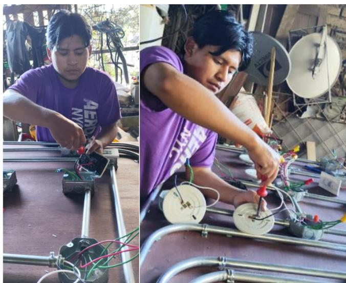
Luego de finalizar la conexión de los equipos destinados a cada circuito de iluminación, es necesario realizar las conexiones de puesto a tierra en las distintas cajas metálicas. Para ello, se utilizan terminales aislados tipo ojo en conjunto con cable THHN calibre #14 AWG. Estos terminales se fijan firmemente a la parte metálicas de las cajas octagonales y rectangulares mediante tornillos, asegurando de esta manera la seguridad de los usuarios, como se indica en la figura 75.
