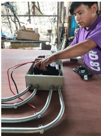
*Nota.* Insertación de los interruptores termomagnético en el centro de carga de 110/220 V.
