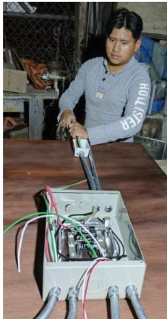
*Nota.* Utilización de cable THHN calibre #8 AWG
