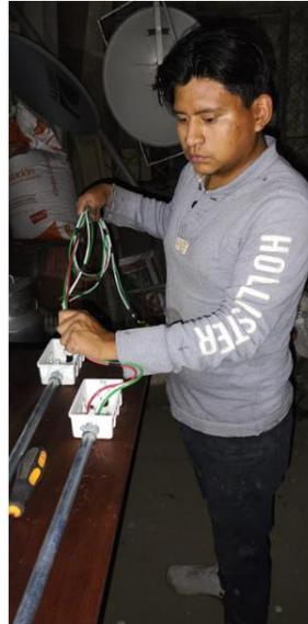
*Nota.* Utilización de cable THHN calibre #10 AWG
