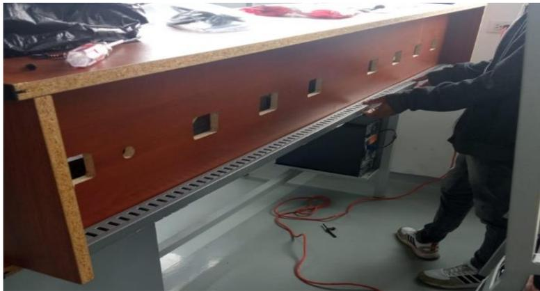
*Nota.* Se instaló la canaleta dexson en la parte exterior de la mesa de trabajo.
