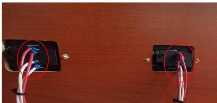
*Nota.* Terminales tipo U usados para las conexiones a los tomacorrientes
