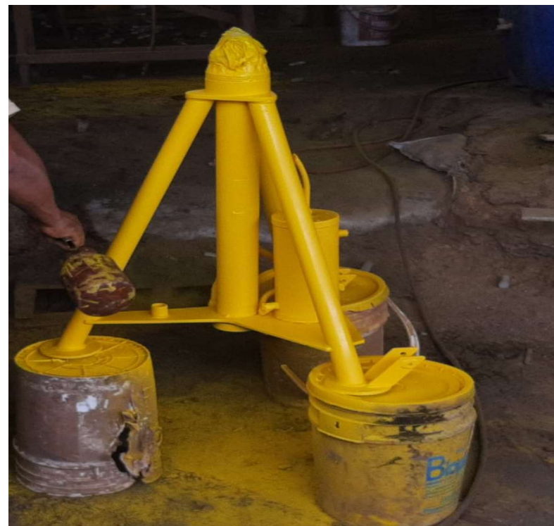
Aplicación de pintura de alta resistencia
