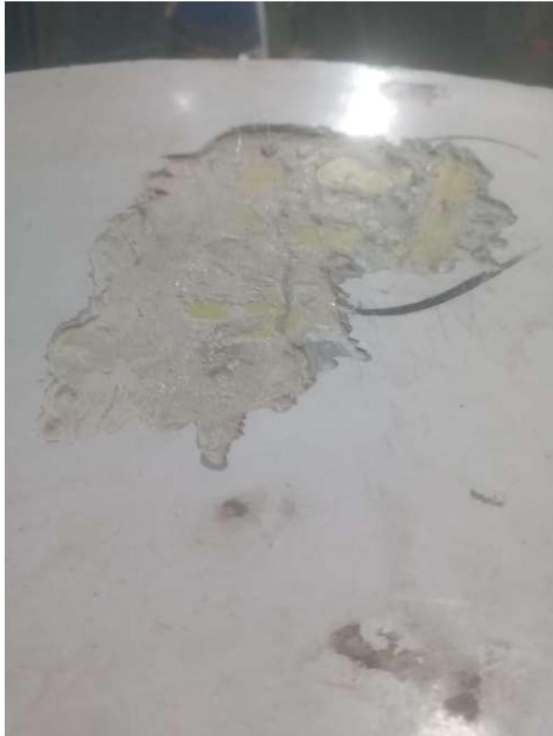
*Nota.* Se puede observar cómo se aplica la resina en los vacíos del área de la superficie de los paneles.
