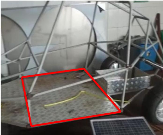
Como segundo punto se realizan los cortes de barra tubular para realizar los limites de la cabina del bastidor.
