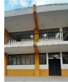
E19 Edificio de aulas
