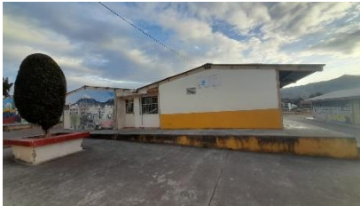
E13 Edificio de aulas
