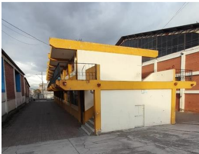
E1 Edificio de aulas y oficinas
