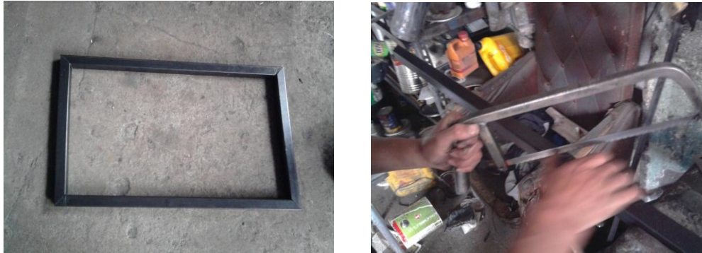
Figura 4.1 Corte del tubo de la estructura.
