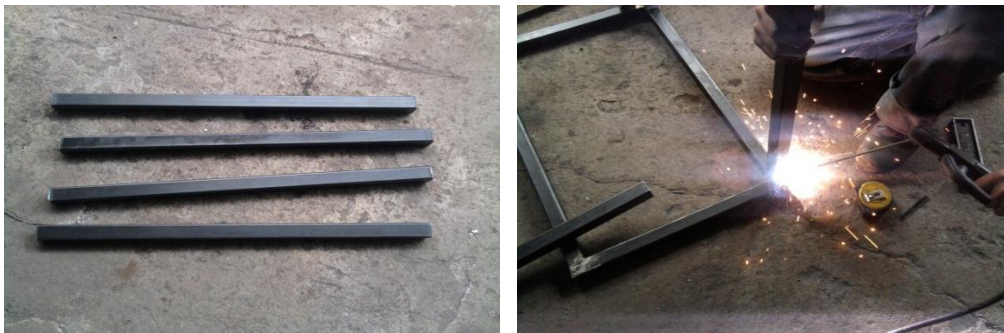
Figura 4.3 Suelda de los tubos de apoyos.
