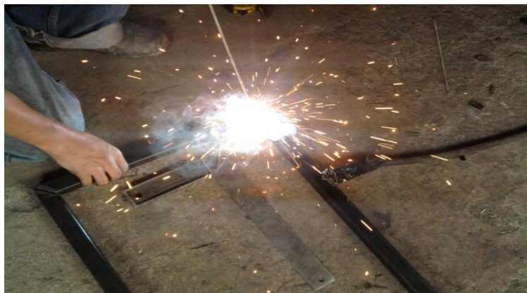
Figura 4.2 Suelda de los tubos
