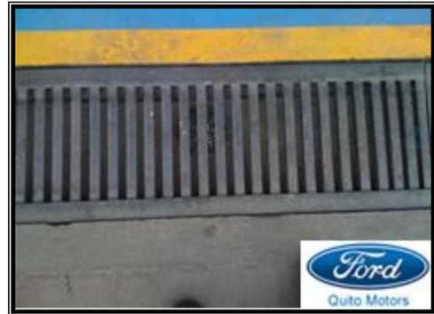
Figura 4.10: Drenaje y trampa de grasa Quito Motors S.A.C.I.
