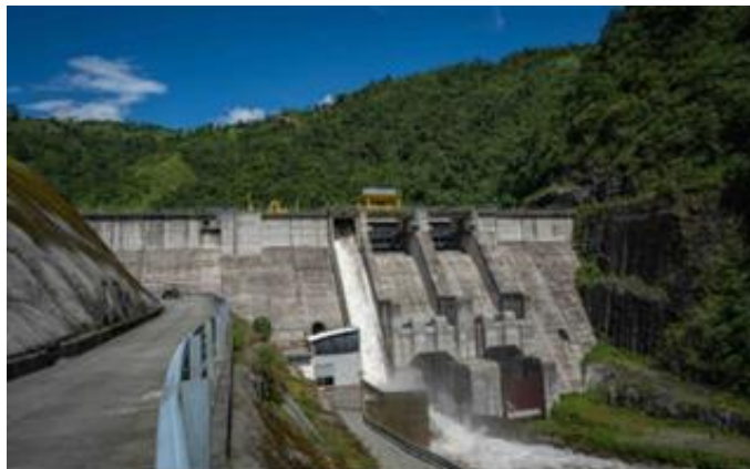
Central de energía Sarapullo
