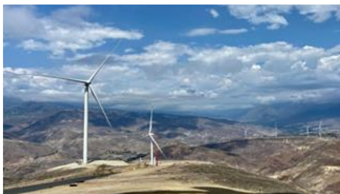
Parque Eólico Minas de Huascachaca
