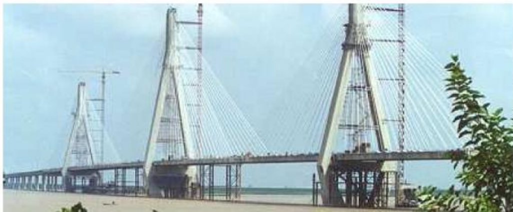
Fig. 1.8 Puente de Lago Dong Ting en China está equipado con aislante de movimiento magnetoreológicos para contrarrestar ráfagas de viento. 6
