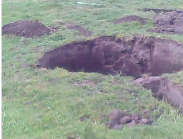
Figura 2.7 Excavación de la fosa.
