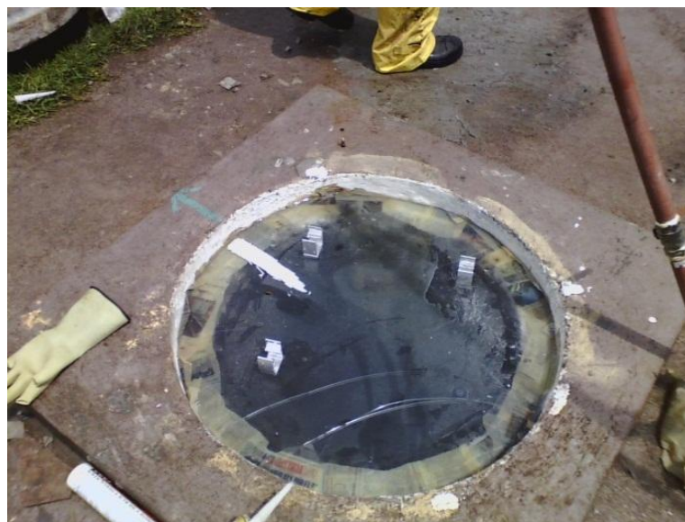
Figura 2.26 Alisado del silicón en la hembra de la tapa
