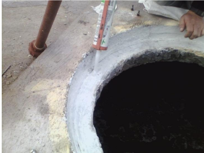
Figura 2.25 silicón en la hembra de la tapa
