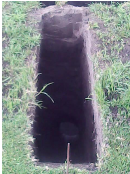
Figura 2.8 Excavación de los ductos
