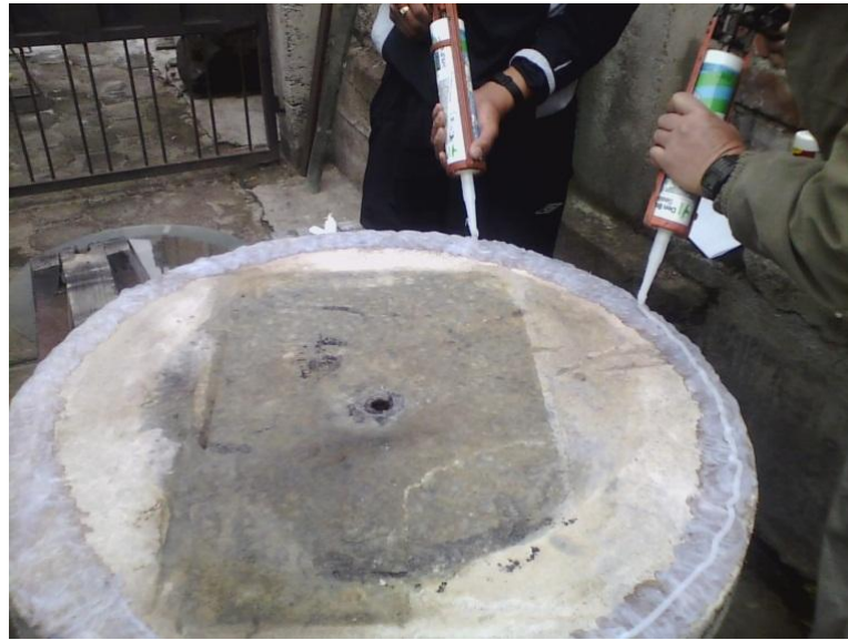
Figura 2.21 Colocacion de silicón.
