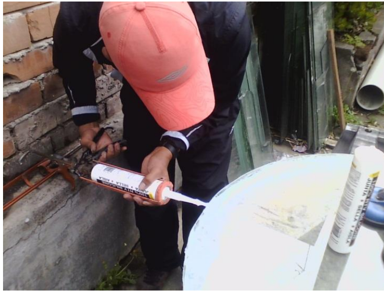
Figura 2.23 Relleno de silicón.
