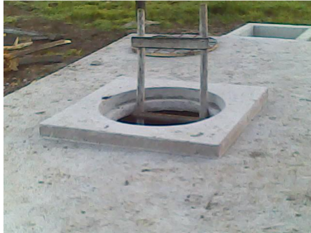
Figura 2.10 loza del tanque reactor
