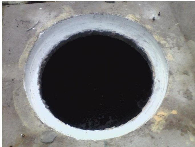
Figura 2.24 Preparación de superficie hembra de la tapa
