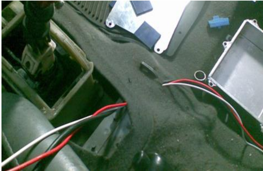
Figura 4.1: Cableado bajo la tapicería
