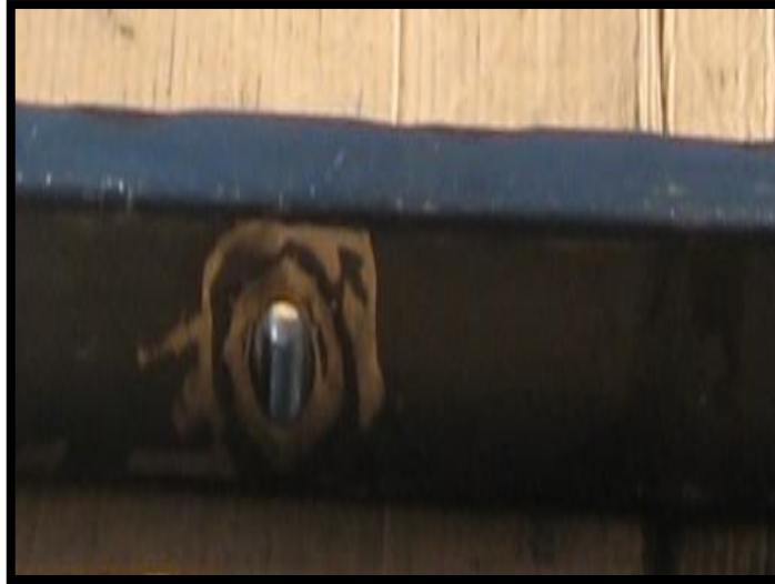
Figura 4.5 Soldadura de casquillo.
