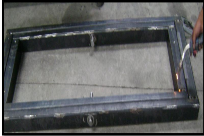
Figura 4.9 Soldadura de tubos perpendiculares .
