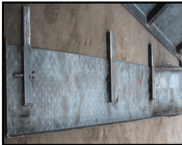
Figura 4.18 Soldadura de extensiones laterales.
