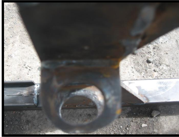
Figura 4.15 Soldadura de orejas de gato hidráulico.
