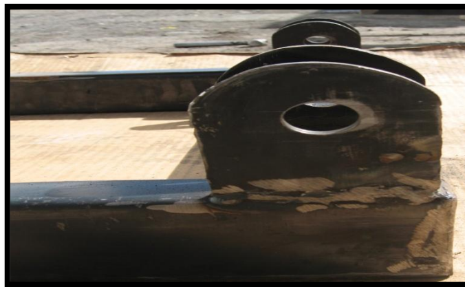
Figura 4.8 Orejas de sujeción.
