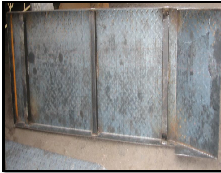
Figura 4.17 Soldadura de largueros.
