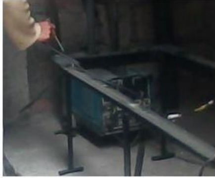
Figura 3.19 Unión de varillas con la base y el ángulo.
