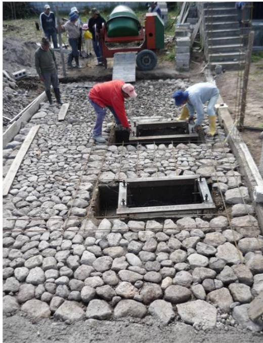
Figura 3.61 Colocación de las bases metálicas
