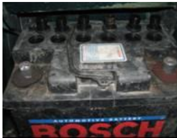
Figura 4.6 Inspección del electrolito.
