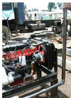
Figura 3.47 Instalación del conducto de evacuación de gases
