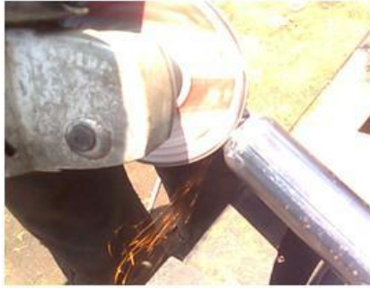
Figura 3.31 Limpieza de rebabas después del corte
