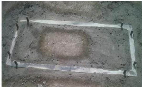
Figura 3.62 Base del molino empotrada en el piso
