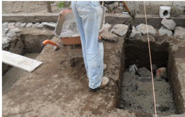
Figura 3.59 Plantilla de hormigón para las bases
