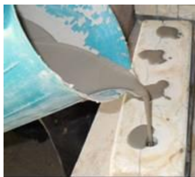
Figura 4.31 Material relleno en los moldes
