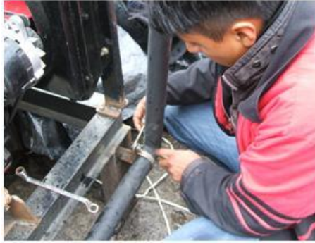
Figura 3.48 Instalación de abrazaderas de sujeción
