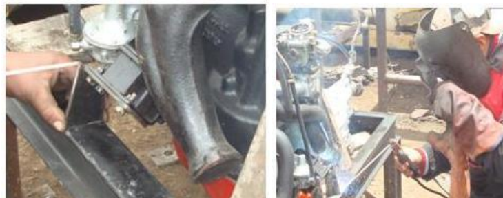
Figura 3.22 Armado y soldado de las bases
