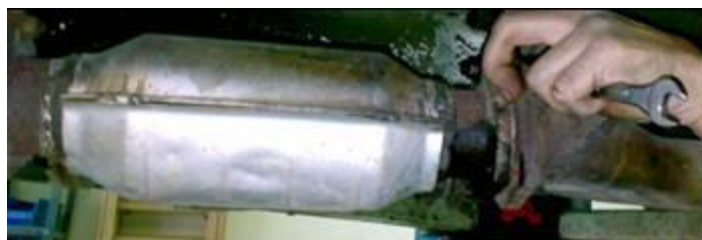
Figura 4.40 Desmontaje del catalizador.
