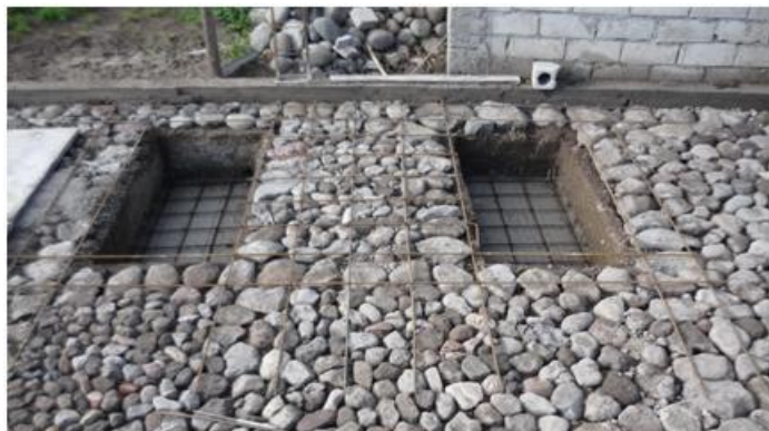
Figura 3.60 Mallas de varilla tendida
