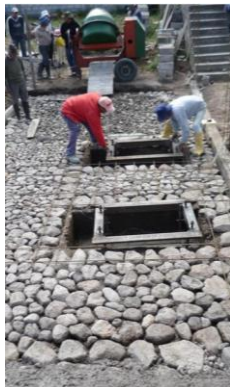
Figura 13. Colocación de las bases metálicas
