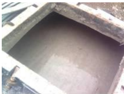
Figura 4.29 Material con aspecto a “sopa de avena”
