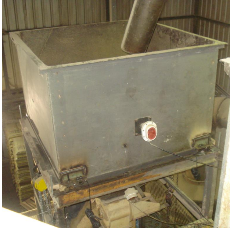
Figura 3.1. Tolva de descarga
