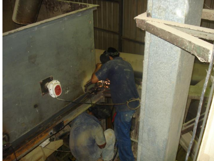
Figura 4.3. Colocación de las bases metálicas en la tolva
