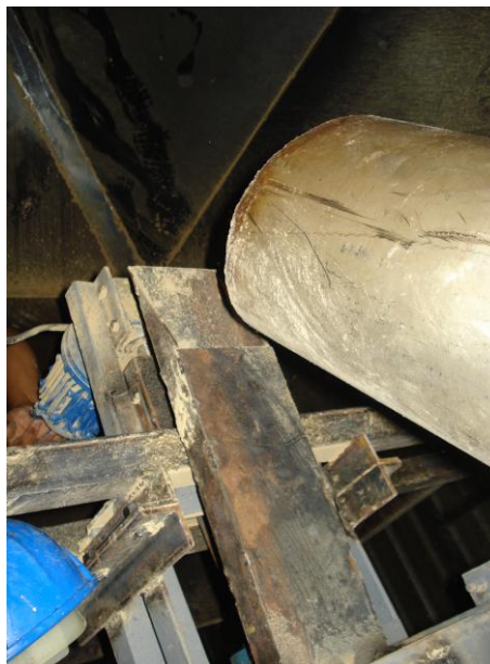
Figura 4.15. Montaje de la máquina dosificadora de encimas
