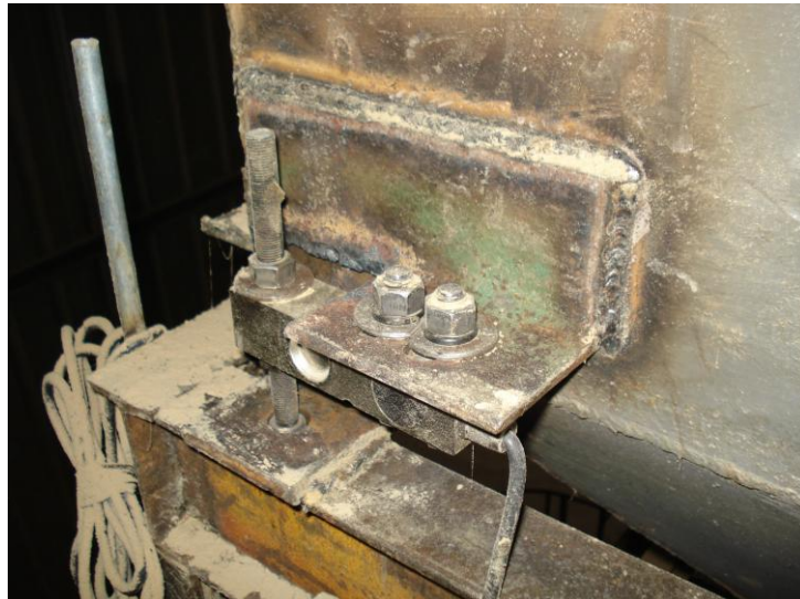
Figura 4.5. Instalación de las celdas de carga
