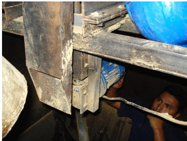
Figura 4.14. Instalación de los motorreductores en la máquina dosificadora
