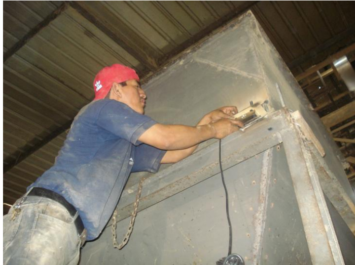
Figura 4.4. Nivelación de las celdas de carga
