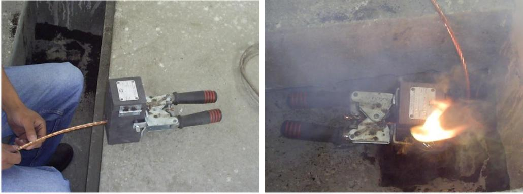
**Figura 4.2.- Preparación y suelda del cable con las varillas cooperweld para la malla de tierra**
