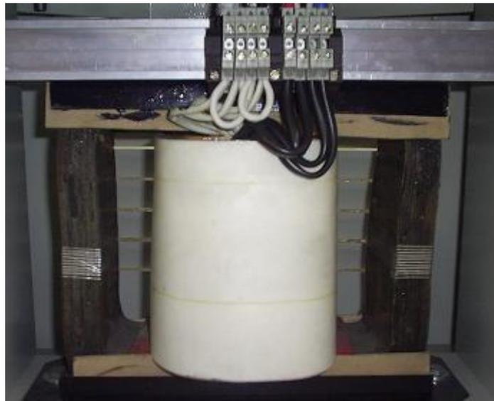
**Figura 4.5.- Transformador de aislamiento del equipo para pruebas de Voltaje aplicado de ELEPCO S.A.**
