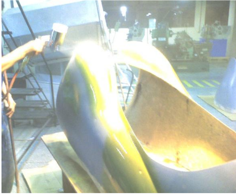
Figura 5.28. Aplicación de la protección ambiental y color del carenado.
