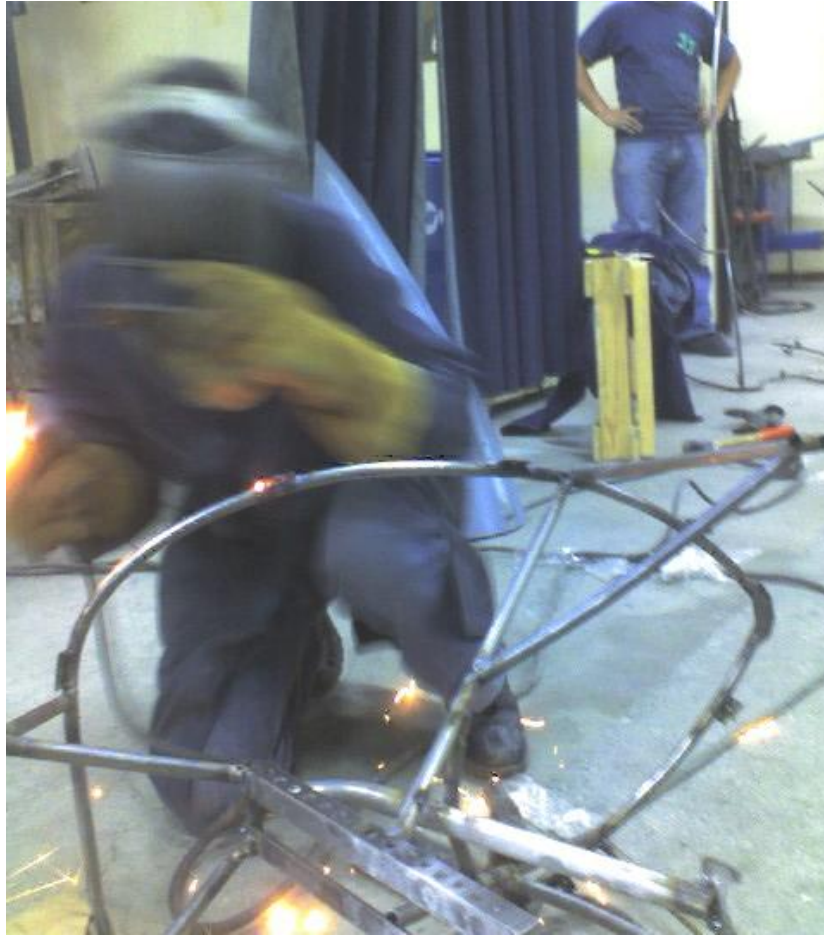
Figura 5.25. Estructura de soporte para el carenado
