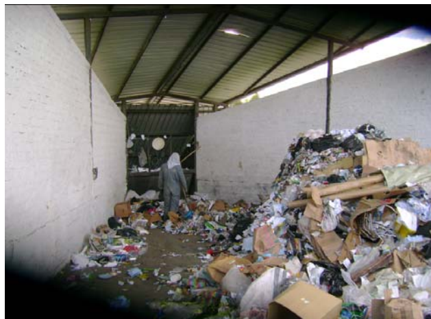
Figura 5.25 Área de descarga y pre-clasificación, planta de reciclaje de la ciudad de Loja
