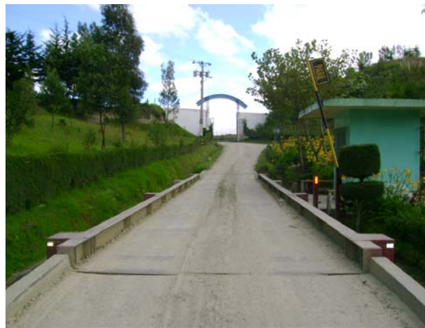
Figura 5.12 Báscula para vehículos de carga, relleno sanitario de la ciudad de Loja
