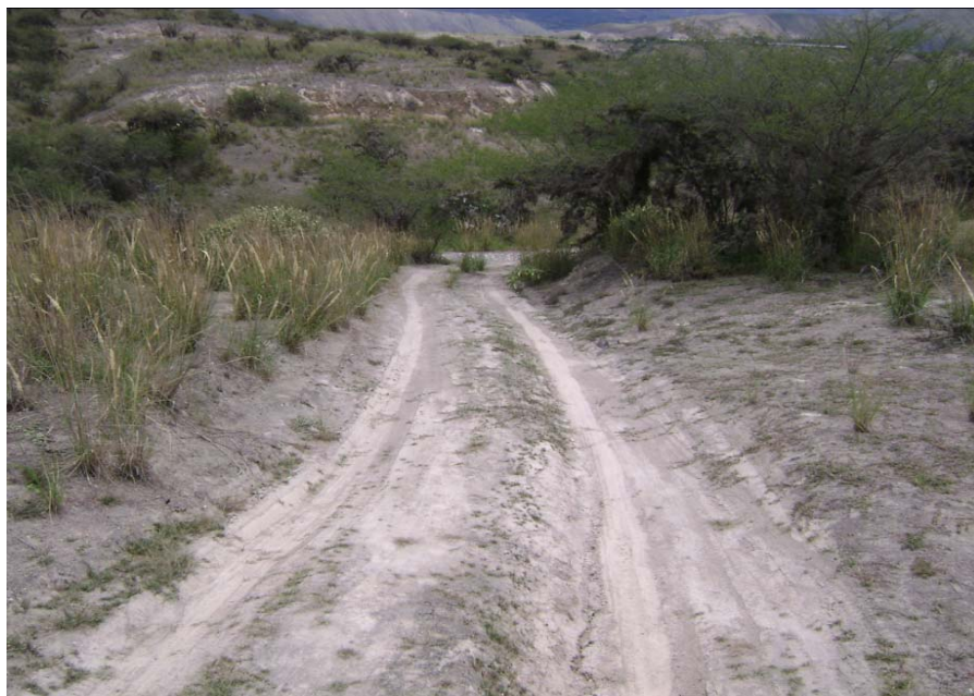
Figura 5.16 Zona alta situada la salida de la planta de reciclaje
