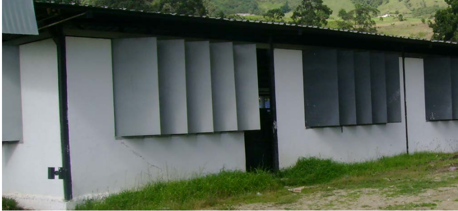
Figura 6.7 Persianas para ventilación
