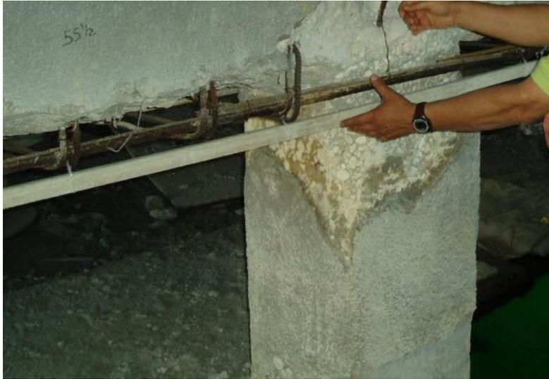
**Figura 5.7: Extracción de material agrietado.**
