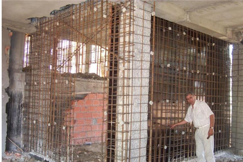
**Figura 5.10: Cambio de un marco estructural a un muro de corte.**
