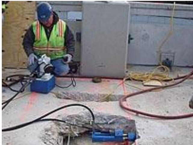
**Figura 5.6: Post-tensión de vigas, proceso que se realiza realizando una abertura en la losa.**
