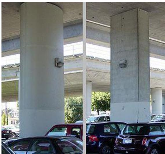
**Figura 5.5: Encamisado de una columna con acero y hormigón armado**
