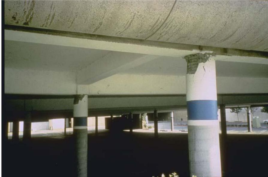
**Figura 1.3: Daño localizado en las columnas de un parqueadero.**
