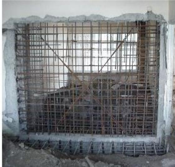
**Figura 5.9: Adición de un muro de corte en una estructura existente.**
