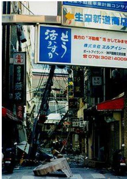
**Figura 1.5: Kobe-1995, Daños no estructurales.**
