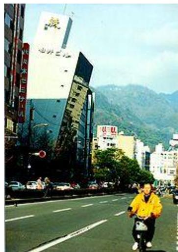
**Figura 1.6: Edificios que fueron derrocados luego del sismo. Kobe-1995**
