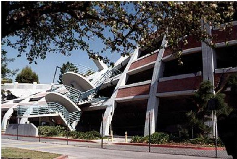
**Figura 1.2: Daño estructural de una Universidad, que debió ser considerada como una estructura indispensable.**
