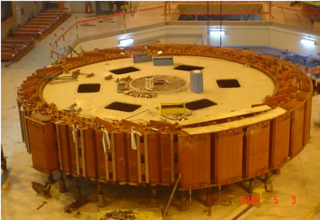
Foto 2. Rotor en proceso de reparación.
