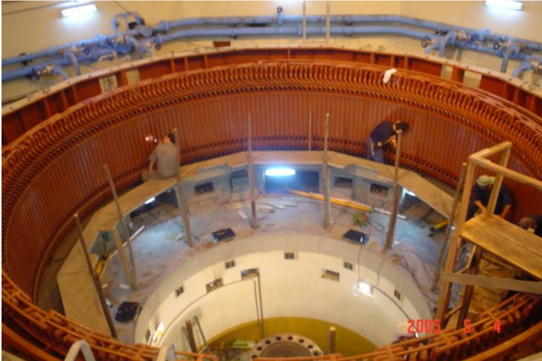
Foto 1. Estator en proceso de inspección.
