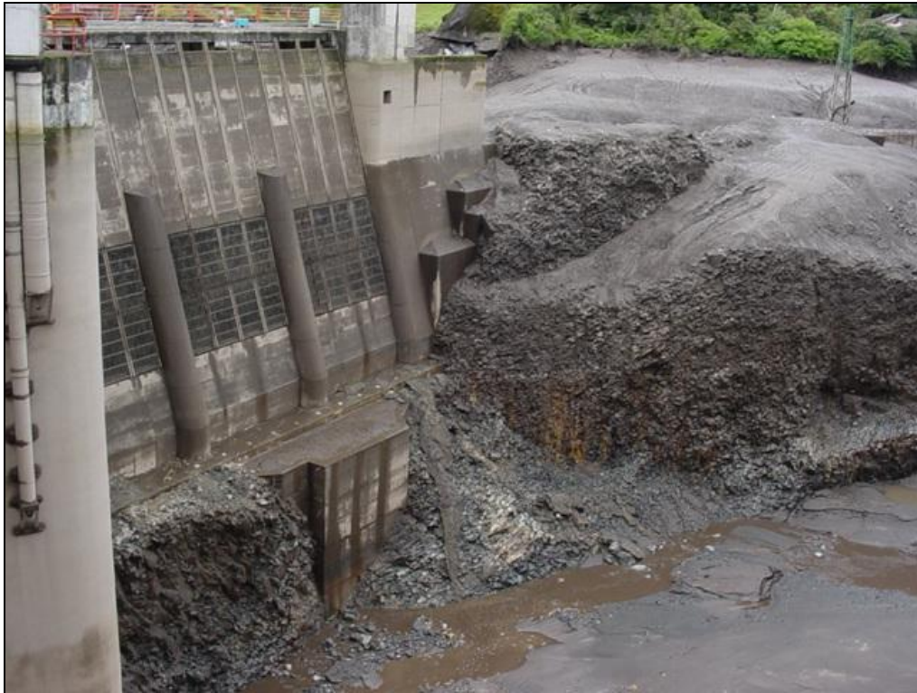
Figura 3.3. Rejillas de obstrucción de sólidos de grandes proporciones.
