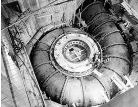
Figura 2.13. Espiral de entrada de una Turbina Francis.
