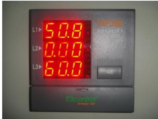
Figura 4.5 – Medición de voltaje y frecuencia VIP396
