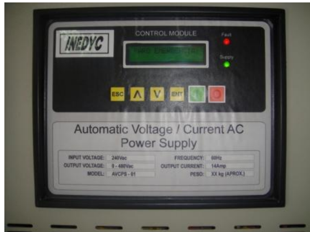
Figura 4.9 – Alarma visual de paro de emergencia
