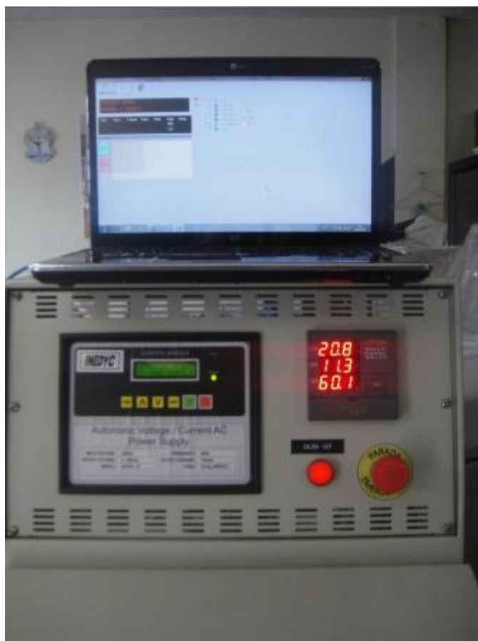
Figura 4.8 – Prueba en mando remoto mediante PC
