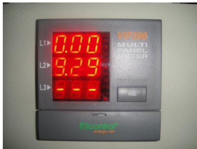
Figura 4.4 – Medición de corriente VIP396
