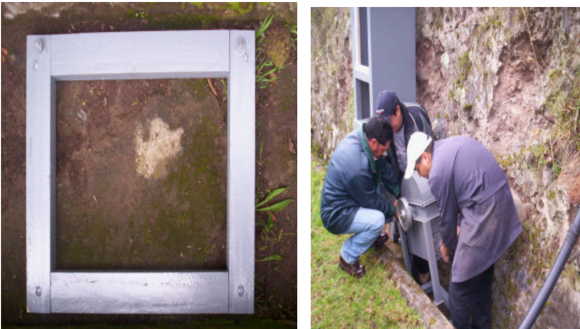
Figura # 5-35 Cimentación de Patas de Pico central
