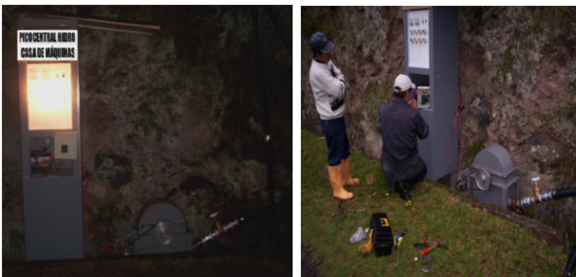
Figura # 5-41 Pruebas antes de la puesta en marcha
