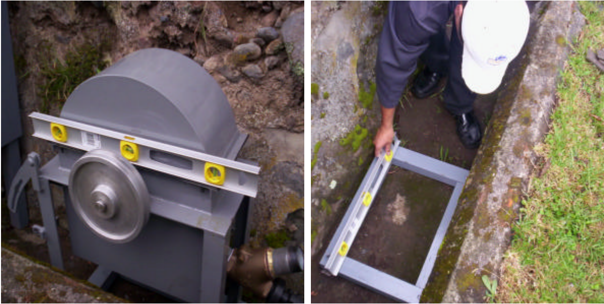
Figura # 5-36 Método empleado en la nivelación del proyecto
