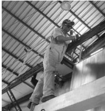
Figura 3.28 Instalación de cableados en canaletas verticales
