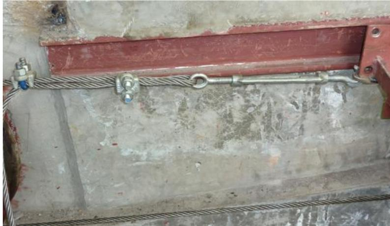
Figura 3.11 Acoplamiento del tensor M16 y la estructura
