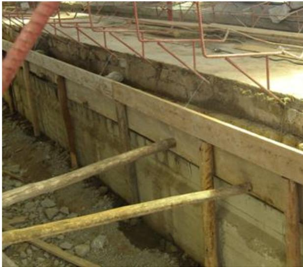
Figura 3.4 Construcción de las paredes
