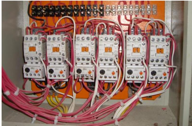
Figura 3.17 Control de Motores
