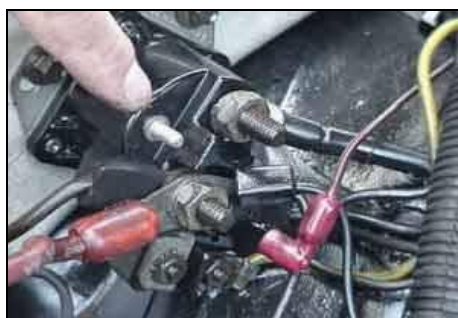
Figura 2.3 Ensayo de tensión de arranque
