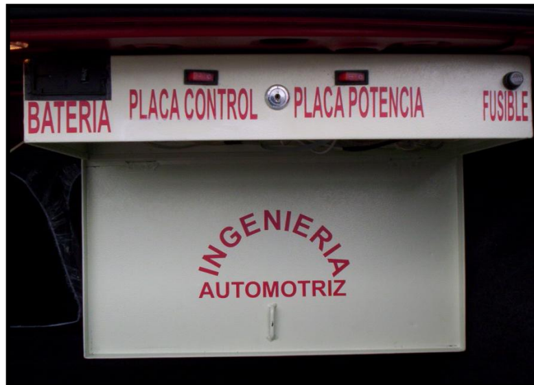
Figura 4.11 Instalación definitiva del módulo
