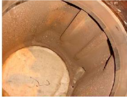
Fig. 4.7 Cámaras de agua en el block
