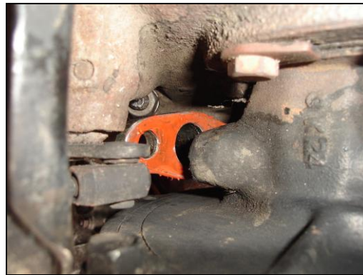
Figura 3.15 Centrado del conducto de retorno.
