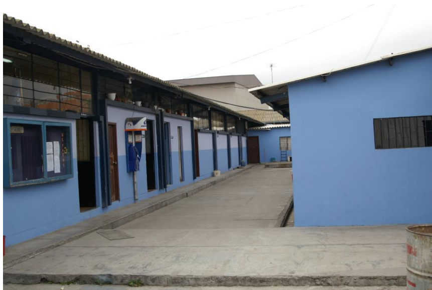
Fig.2.3 Instalaciones del Ala No. 12
