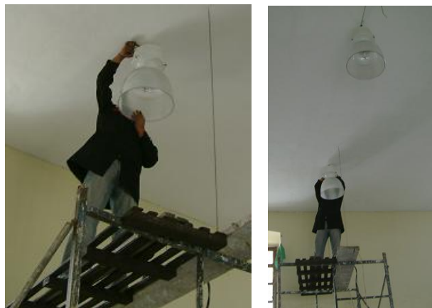
Figura 5. 5. Instalación de las lámparas
