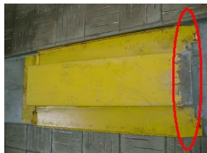
Figura 6. 93. Rampa deteriorada
