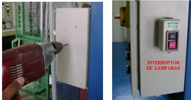
Figura 5. 7. Instalación del interruptor de las lámparas
