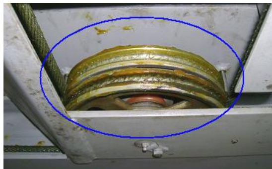
Figura 6. 84. Limpieza y lubricación de poleas
