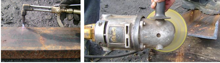
Figura 4.3. Cortado y pulido riel principal del puente corredizo
