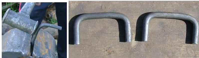
Figura 4.11. Construcción de agarraderas
