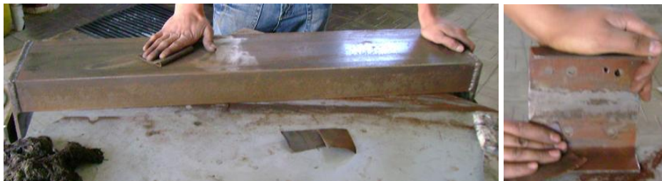
Figura 4.17. Limpieza de residuos y preparación de los elementos para pintura general
