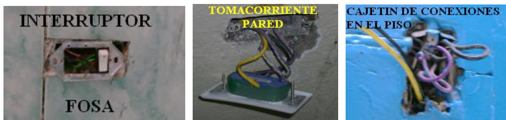
Figura 5. 9. Revisión tomacorrientes e interruptores
