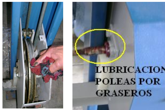
Figura 6. 78. Limpieza y lubricación de poleas
