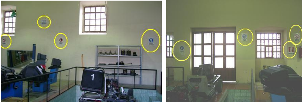
Figura 5. 34. Instalación de las rotulaciones
