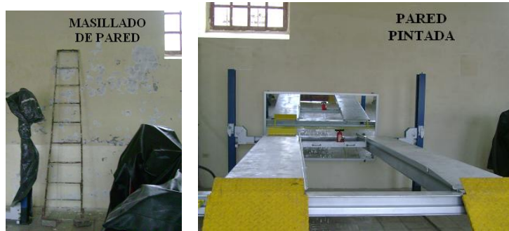
Figura 5. 23. Proceso de pintado de la pared
