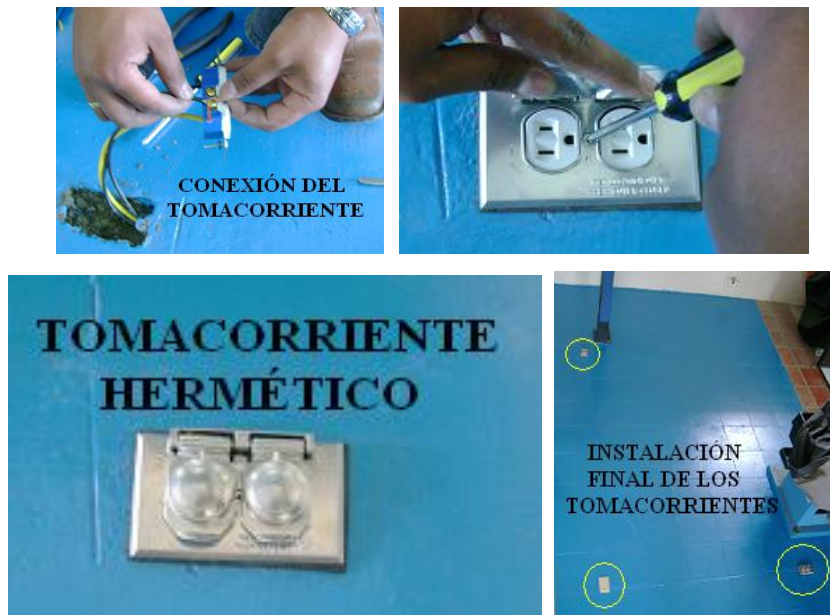
Figura 5. 14. Instalación de tomacorrientes herméticos
