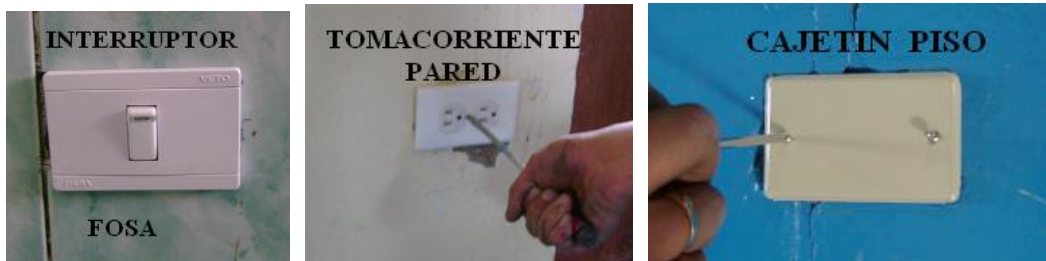
Figura 5. 10. Reparación de tomacorrientes e interruptores
