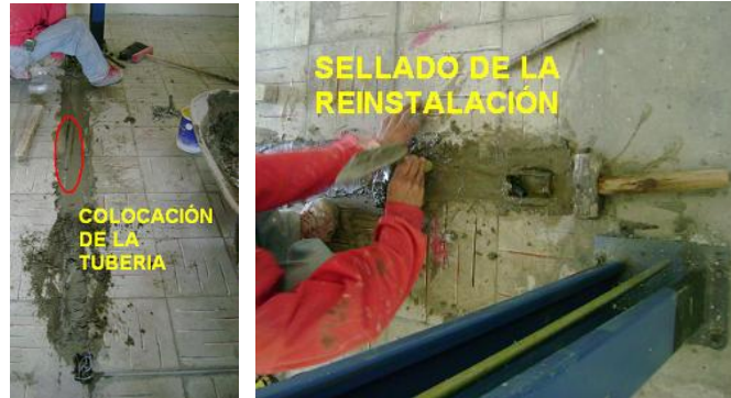
Figura 5. 13. Preparación del piso
