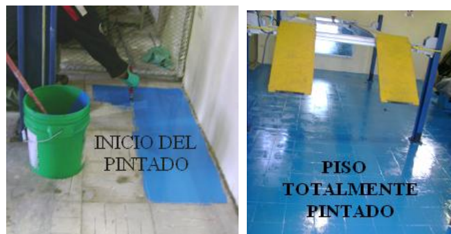
Figura 5. 28. Proceso de pintado del piso
