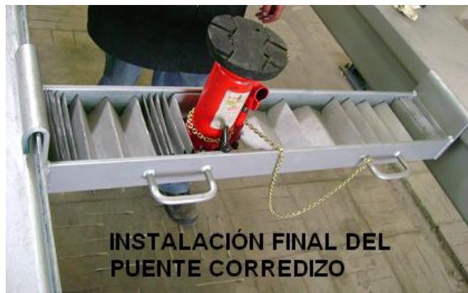
Figura 5. 21. Colocación del puente corredizo
