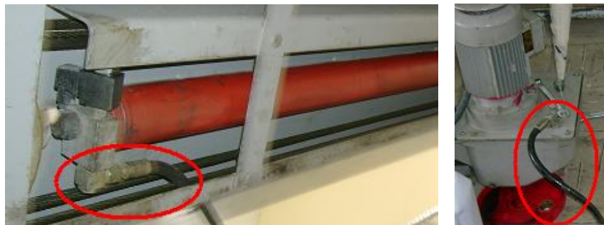
Figura 6. 88. Verificación de fugas en cañería
