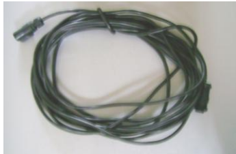
Figura 6. 10. Limpieza de cables
