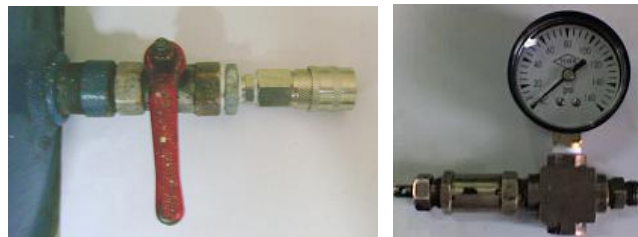
Figura 5.16. Colocación de los acoples en el compresor
