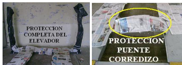
Figura 5. 22. Colocación de protecciones para realizar el pintado de la pared
