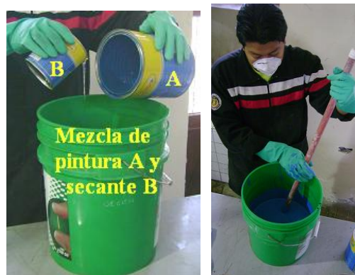
Figura 5. 27. Preparación de pintura
