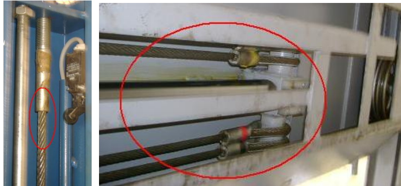
Figura 6. 80. Inspección de cables
