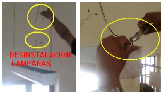
Figura 5. 2. Desinstalación de las lámparas fluorescentes
