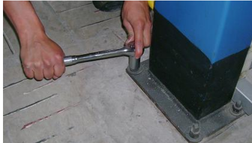
Figura 6. 89 Reajuste pernos de empotramiento
