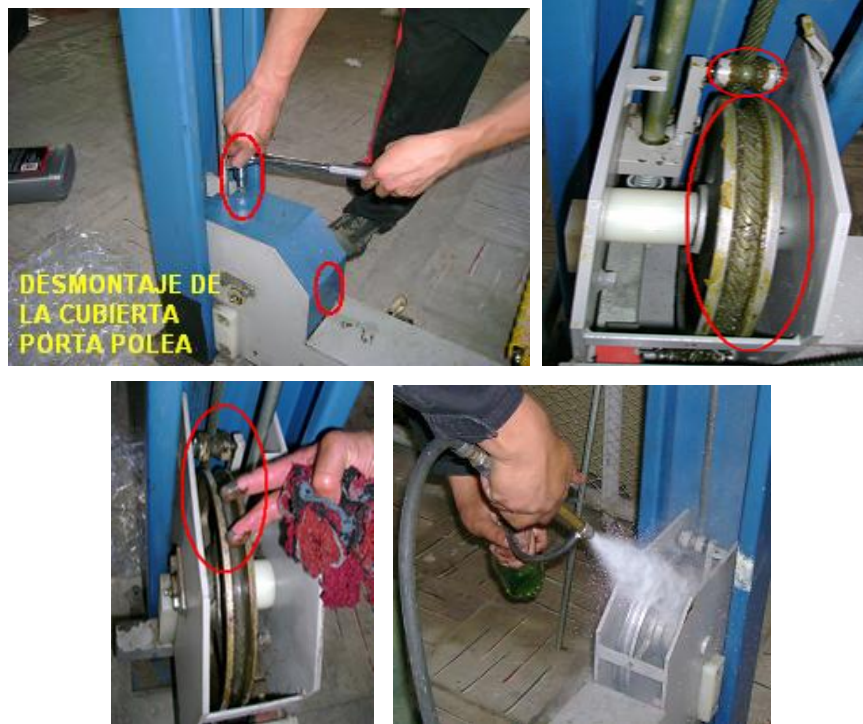
Figura 6. 77 Lavado y pulverizado de poleas
