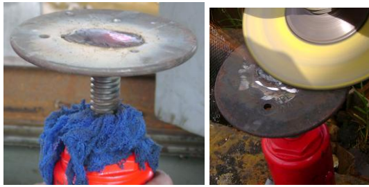
Figura 4.16. Construcción de un soporte para el gato hidráulico
