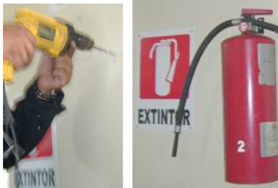
Figura 5. 29. Colocación del extintor
