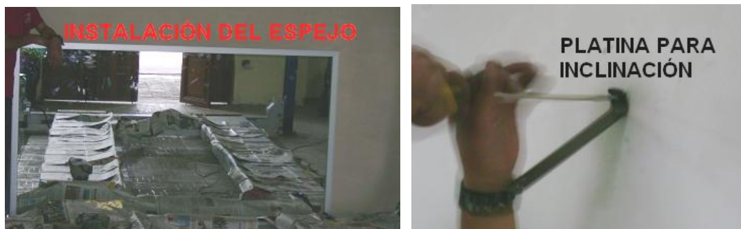
Figura 5. 19. Preparación para la colocación del espejo
