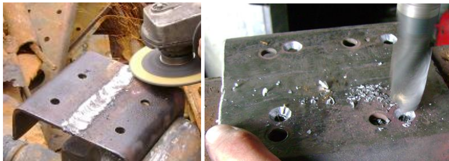
Figura 4.14. Armado, soldado, pulido y perforado de la placa base
