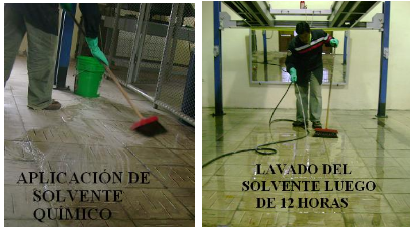
Figura 5. 26. Proceso de preparación del piso
