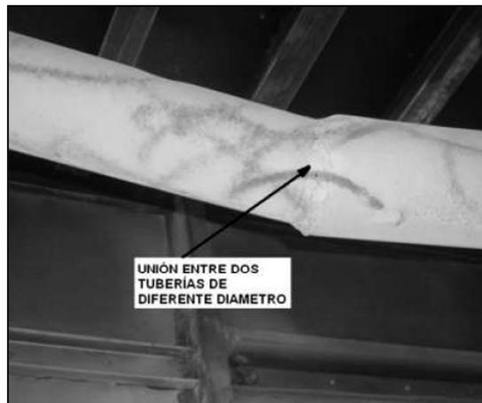
Fotografía 03: Cambios de sección del tubo de escape
